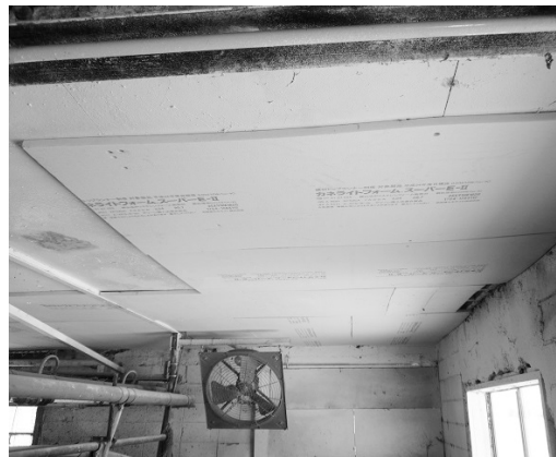
写真1 天井や壁に断熱材を取り付けた牛舎
