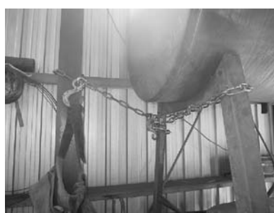
写真3 燃料タンクの転倒防止対策 (中川農場事例)
