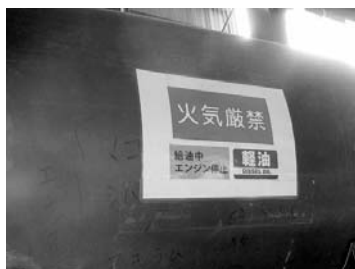
写真1 燃料タンクへの火気厳禁表示 (中川農場事例)
