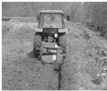
写真 溝掘機による明きよ施工
