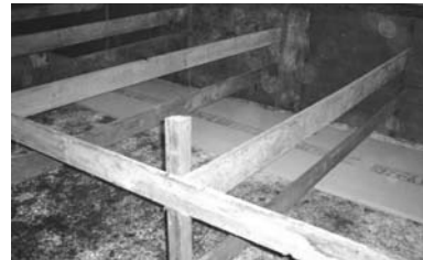
写真2 断熱材を使った事例
