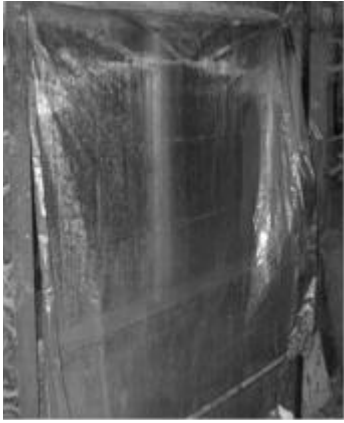
写真1 ビニール設置の事例
